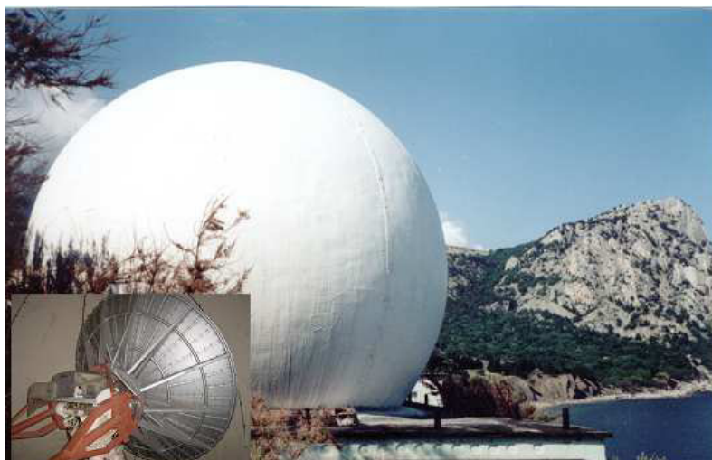
Рис. 3. Радиотелескоп на частоты 2.5 и 2.85 ГГц в радиопрозрачном куполе
