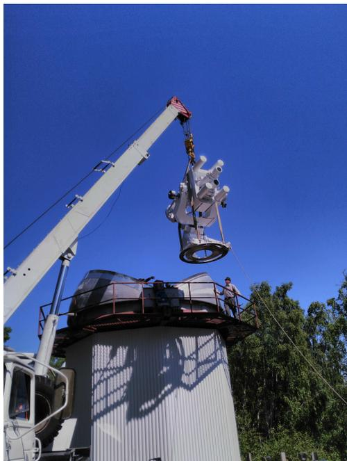
**Рис. 4.** Этап монтажных работ по установке СОЛСИТ в башню
